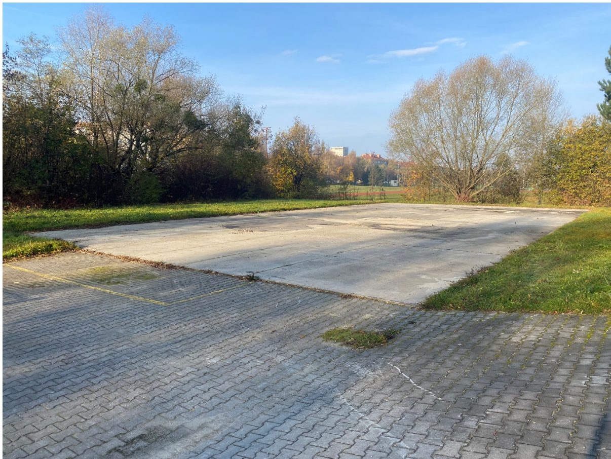
Fotografie místa stavby
