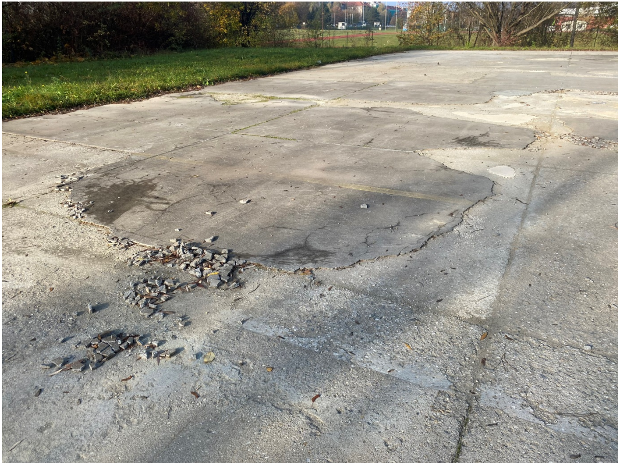
Fotografie nutného odstranění asfaltové vrstvy a začištění betonové desky
